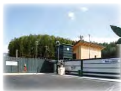
木質バイオマス発電「森林の発電所」
