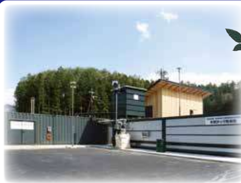
木質バイオマス発電「森林の発電所」
